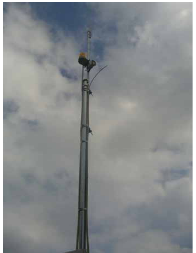
88 6.3mメインポールに、51薄鋼電線管をサブポールとして抱かせて使用
