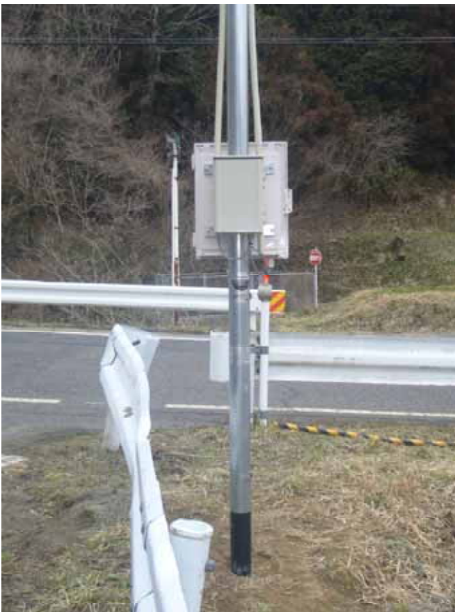
降雪地域のためGLから、本体底部まで1500mm以上の高さをとって設置
