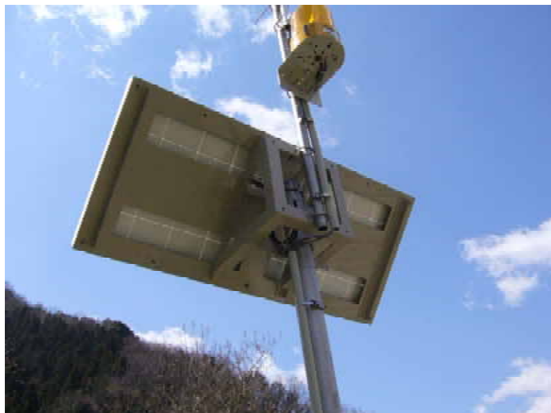
φ89鋼管柱 地上高4mの施工例
