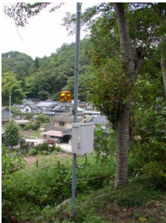
50 柱を建柱 電源は商用(公会堂から) 小高い丘の上にて、見通しの良いこの位置に
