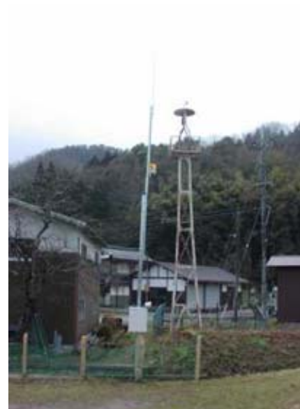
グラウンド脇に設置
