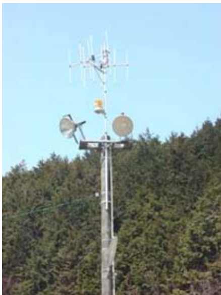
グラウンドの照明灯に設置 指向性アンテナで2方向を探知
