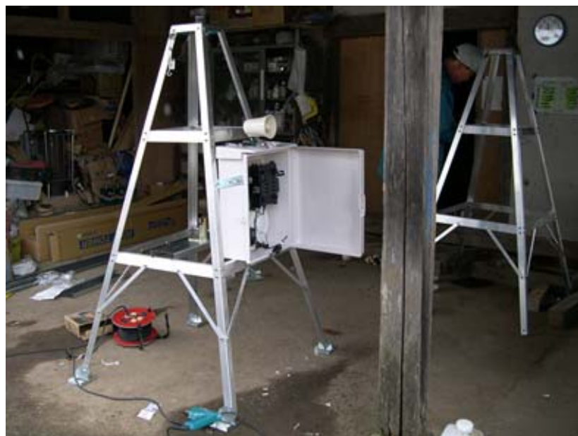
アルミ製ルーフトワーに取付中の様子 これら組立は、現地に対応していただきました
